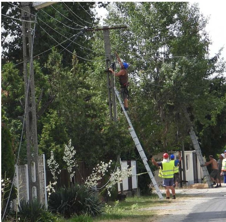
Hírközlési hálózatépítés (építésfelügyeleti ellenőrzésen)
