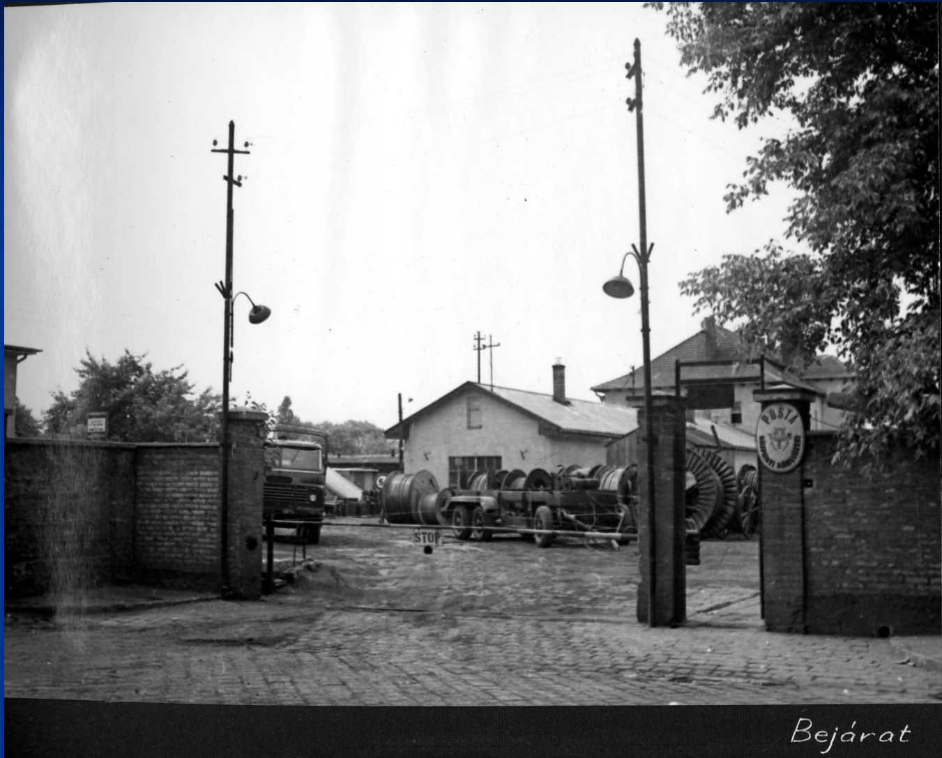
A Posta Központi Kábelüzem, Bajtárs utcai telephely, építés bejárata.
