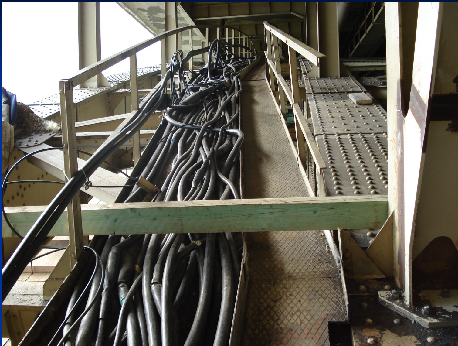
Margit-hídi kábelcsatorna 2010.
