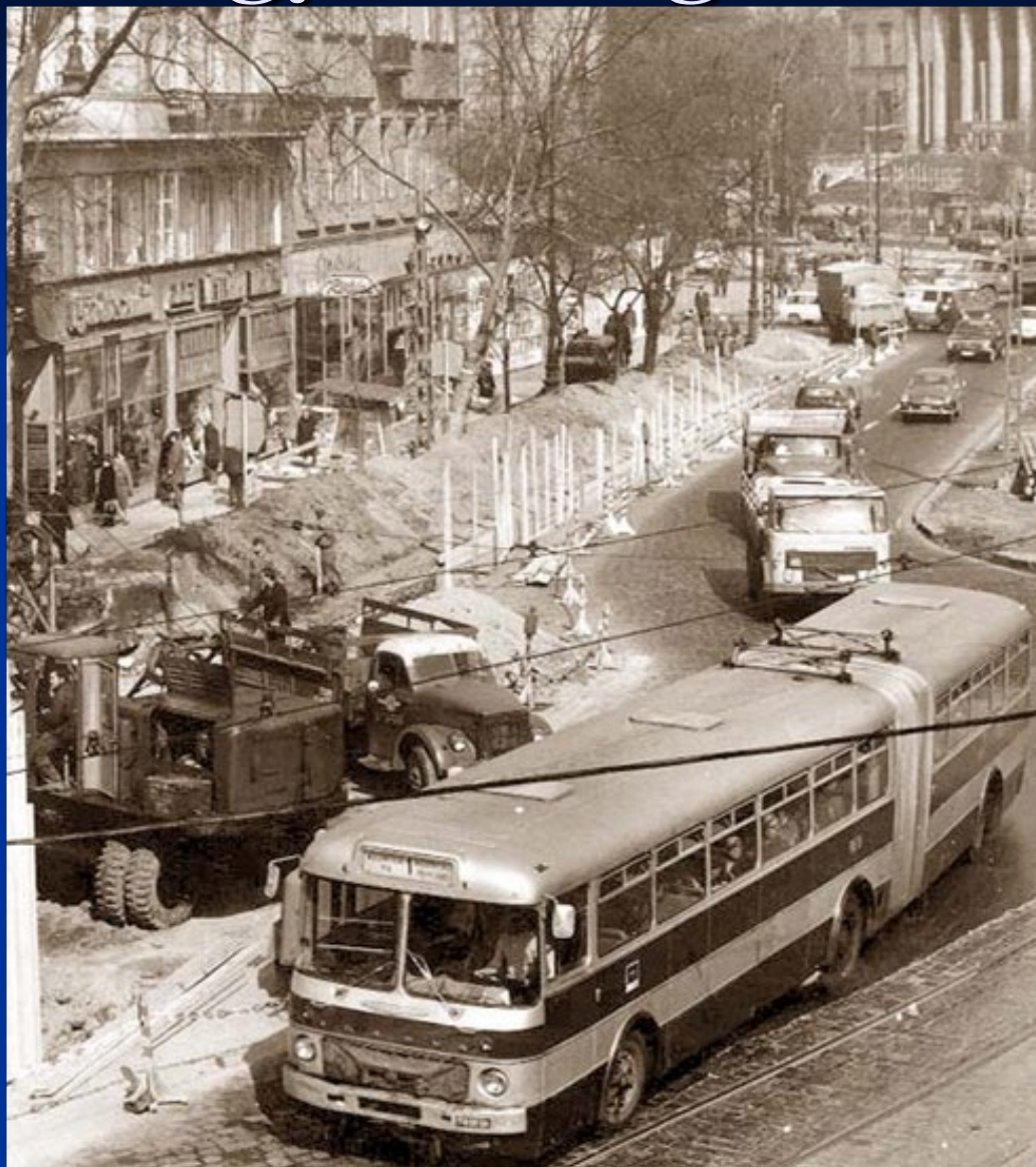
Alépítmény építés a Kálvin téren
