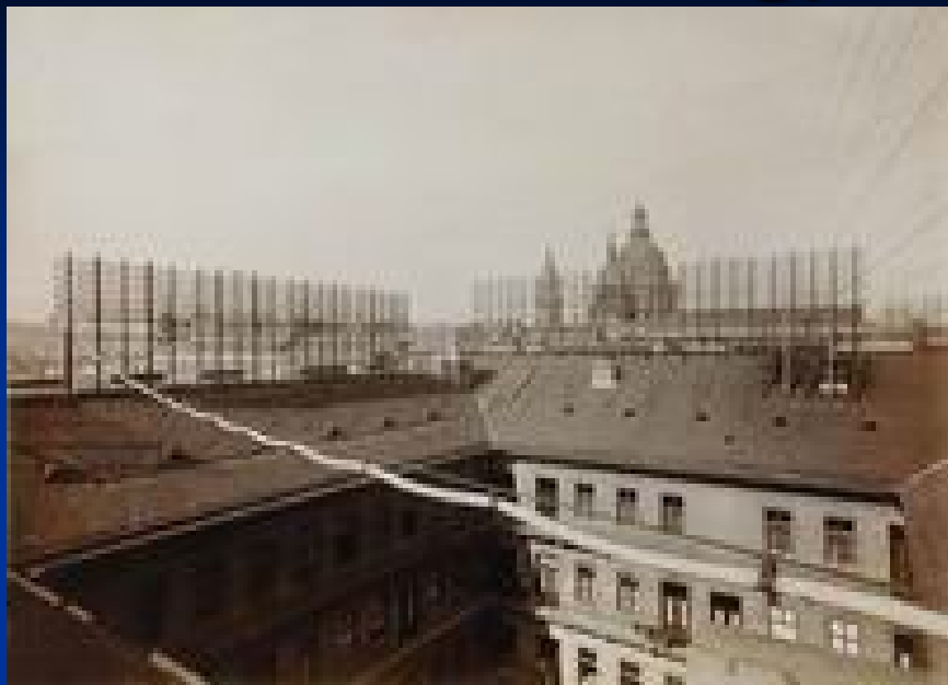
Légvezetékes kiindulási tetőtartók a Szerecsen utcai központ tetőszerkezetén.
