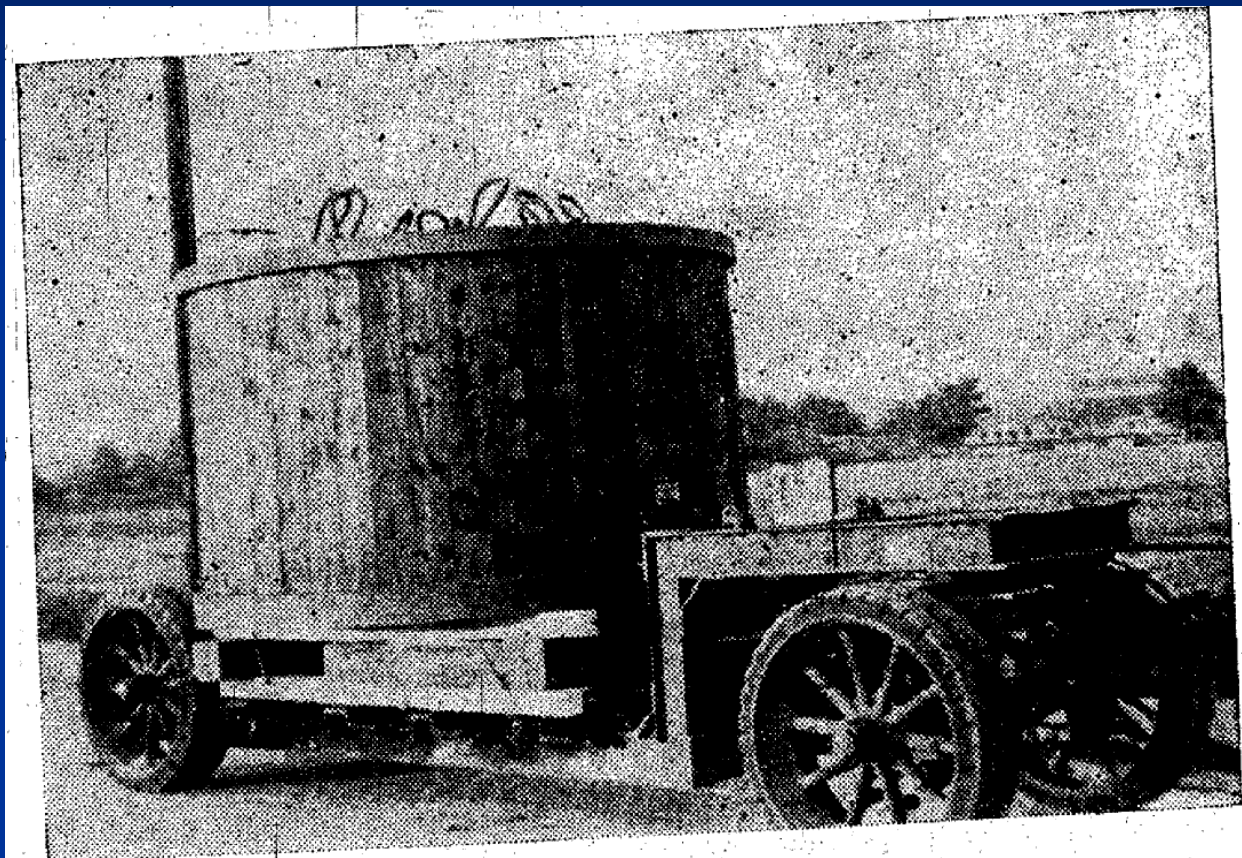
A Dunaföldvári folyamkábel fektetés 1939. okt. 20-21.
