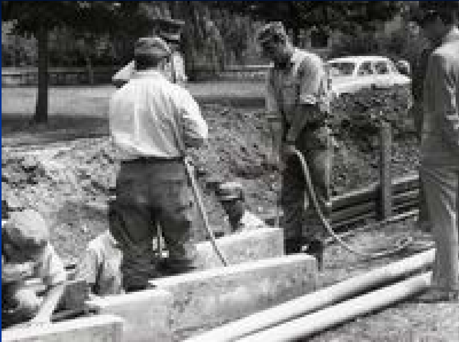
IV betoncsatorna egység fektetése Tatabányán 1964-ben.
