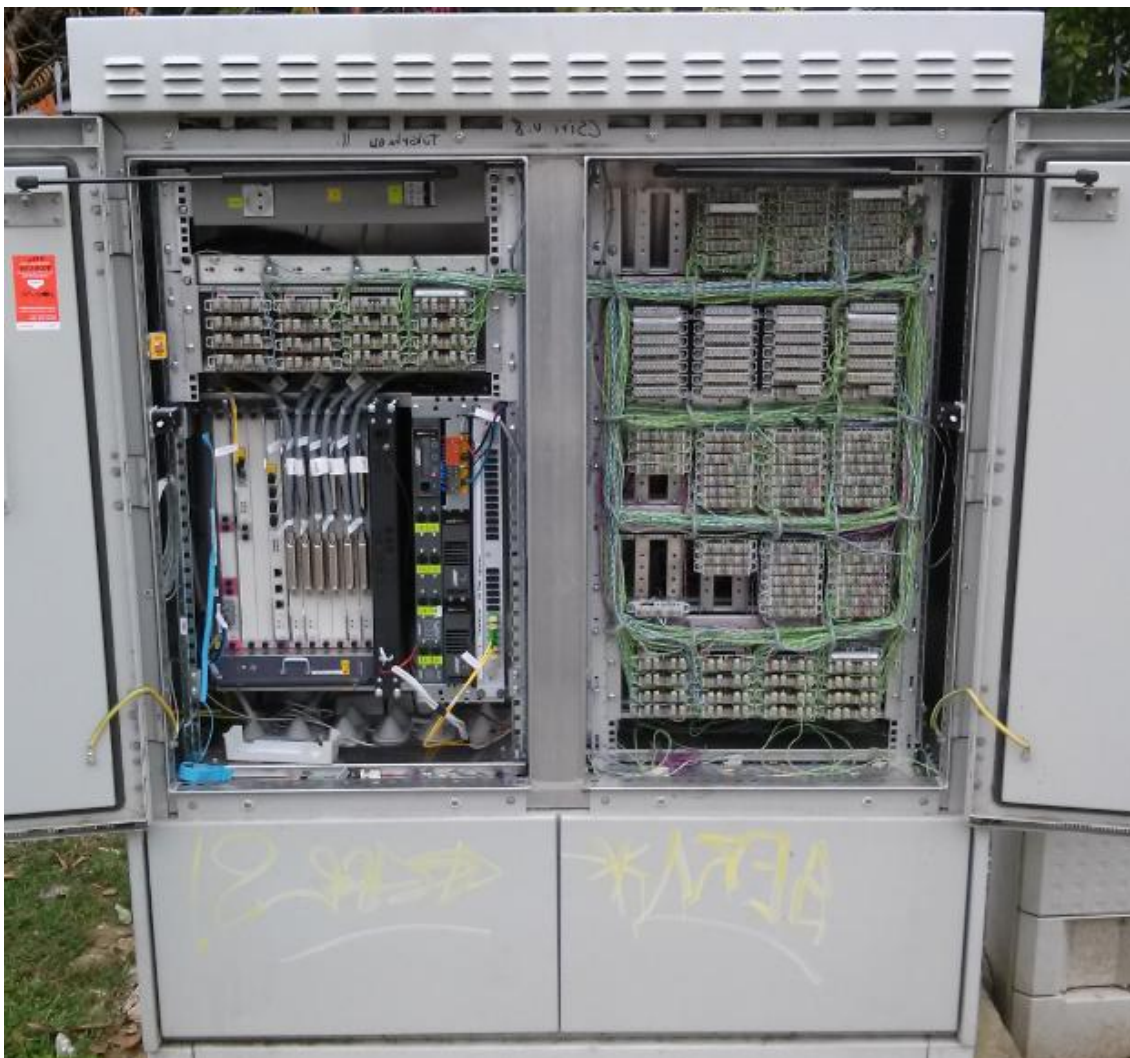
Közepes MSAN berendezés létesítése meglévő KE-02TH kabinetben
